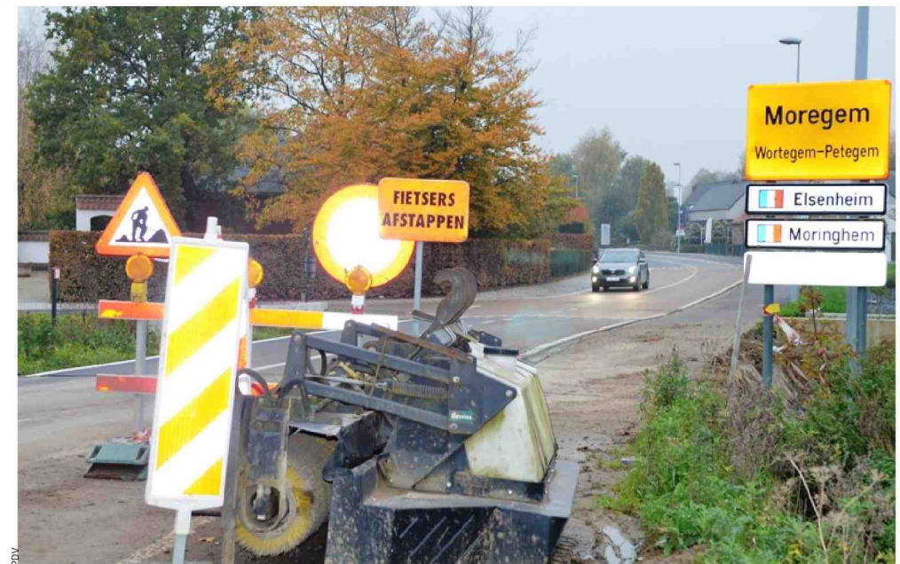
De heraanleg van de Oudenaardseweg is achter de rug. Doorgaand verkeer is wel nog verboden. De weg opent volgende week.
